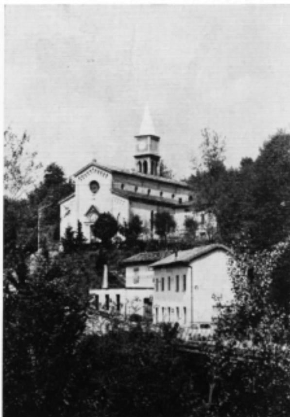
La chiesa parrocchiale di San Pietro di Ragogna, non lontano dal lago che prende il nome dal paese, e non lontano dal castello, ora diruotato, che troviamo citato da Venanzio Fortunato: « et super insat aquis Reunia Tilimentis ».
