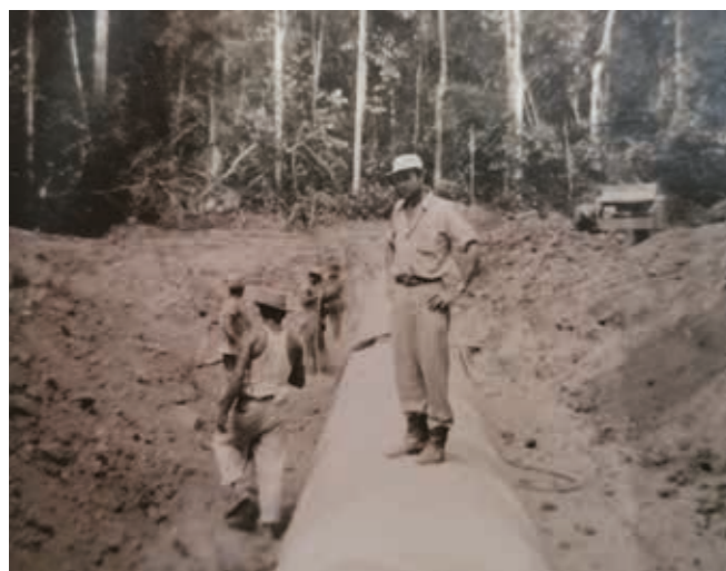
■ Aldo Micelli Peressini in visita a Friuli nel mondo (sopra) e, a sinistra, nel 1958 sul cantiere della strada Eldorado-Santa Elena
